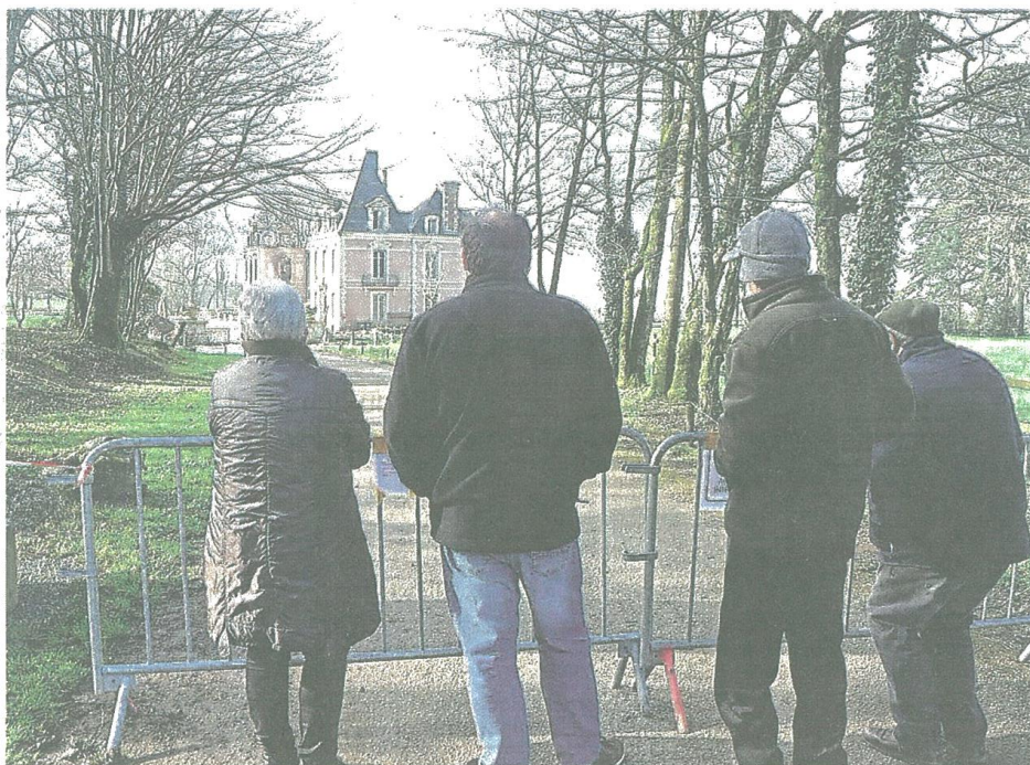
Petit Chêne, dimanche. Hier, au lendemain de l'incendie qui a fortement endommagé le château, les Gâtinais sont venus constater l'ampleur du désastre.
