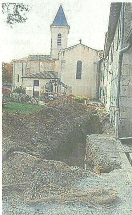
Les travaux continuent à la mairie.
