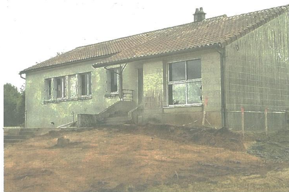
Le nouveau terrassement de la nouvelle bibliothèque.
