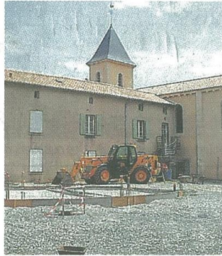
Les travaux à l'arrière de la mairie ont commencé.
