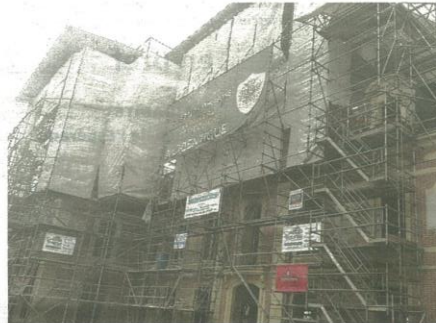
Les travaux de rénovation de l'imposante bâtisse doivent s'achever l'été prochain.
