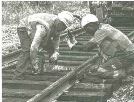
La première phase de travaux entre Niort et Parthenay s'est déroulée entre avril et juin 2018.
