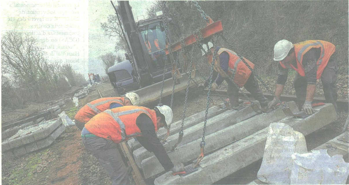
Les travaux de remise en état de la voie ferrée sont entrés dans leur phase active. Visite du chantier. (Photo NR, Éric Pollet)
